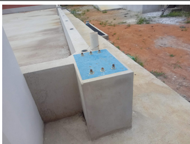
Imagem 3 – Placa de base/chapa de transição (estrutura metálica da cobertura)
