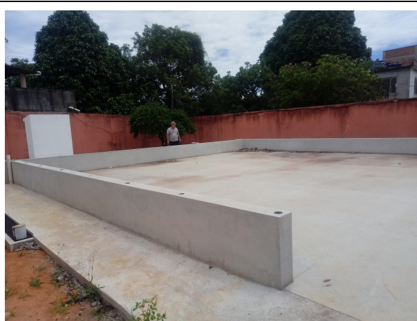
Imagem 4 – Mureta de blocos de concreto (suporte para afixação do alambrado)
