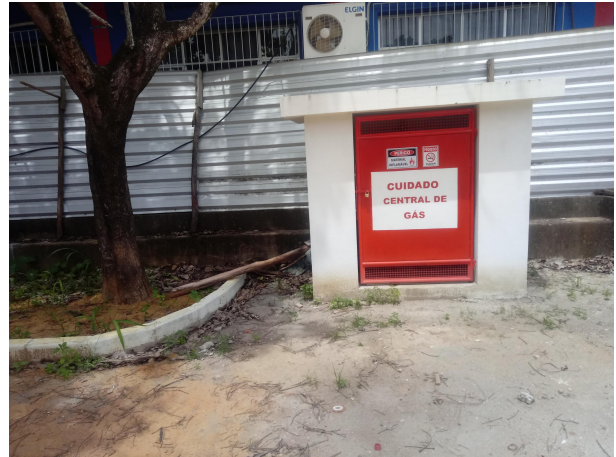
Imagem 6 – Abrigo de Gás
