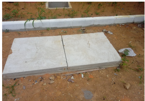
Imagem 8 – Caixa de passagem (esgoto)
