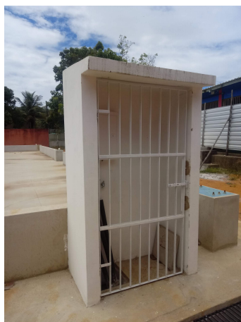
Imagem 9 – Abrigo do QGBT (quadra)
