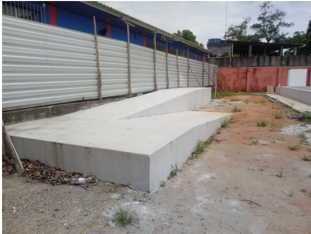
Imagem 5 – Rampa de acessibilidade (faltando ainda a instalação do guarda-corpo)
